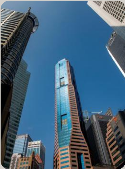
中央商业区 新加坡金融与商业中心，仅三个地铁站之遥。
